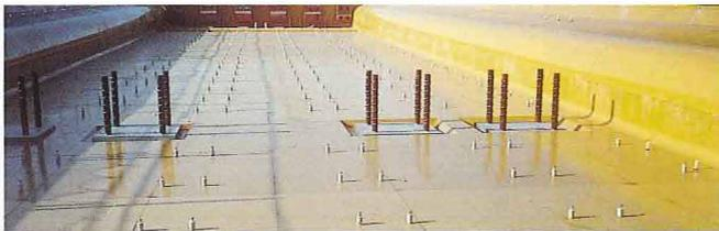
**3** 主筋およびスターラップ筋取付後、ワインディングパイプの取付、浮止め防止。
